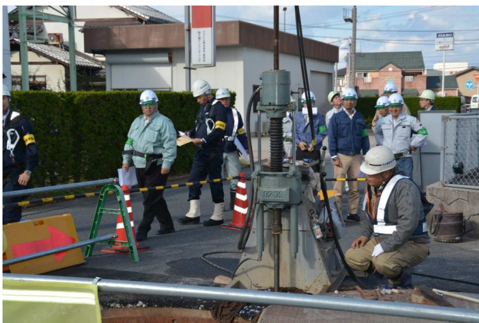
工事現場の作業状況や立入禁止措置等を確認。
