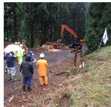
伐木等機械（プロセッサ）の作業場所の安全対策を確認。
