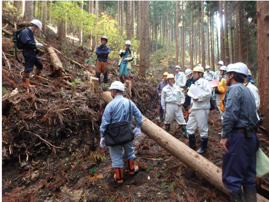
パトロールの様相（10月27日午後、西部地区作業現場にて）
